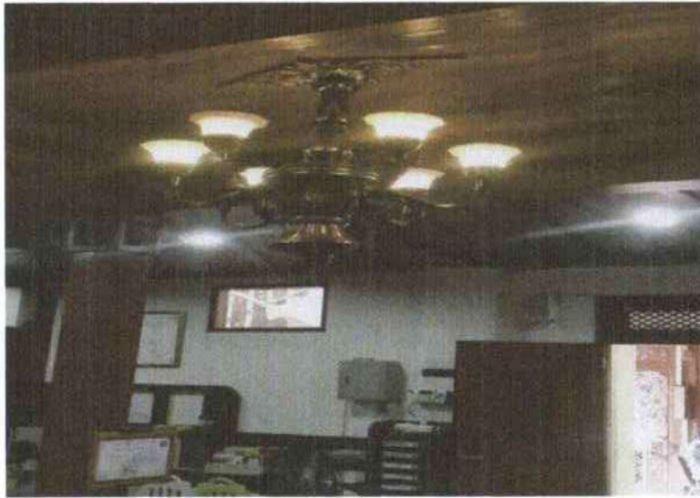
Gambar 3. Mengganti Lampu Ruang Pelayanan Publik
