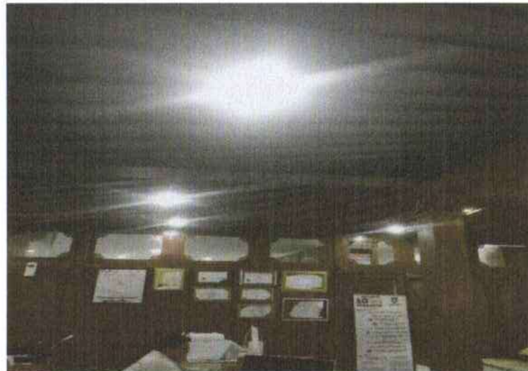
Gambar 2. Mengganti Lampu Ruang Pelayanan Publik
