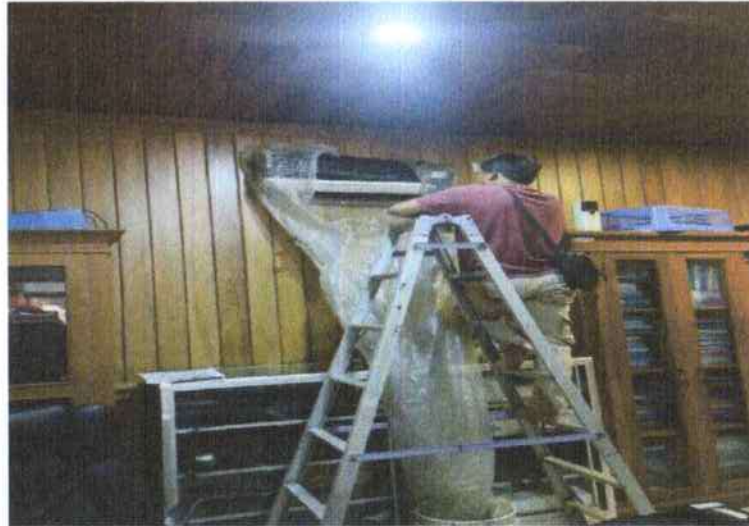
Gambar 1. Service Pemeliharaan AC Ruang Pelayanan Publik secara rutin
